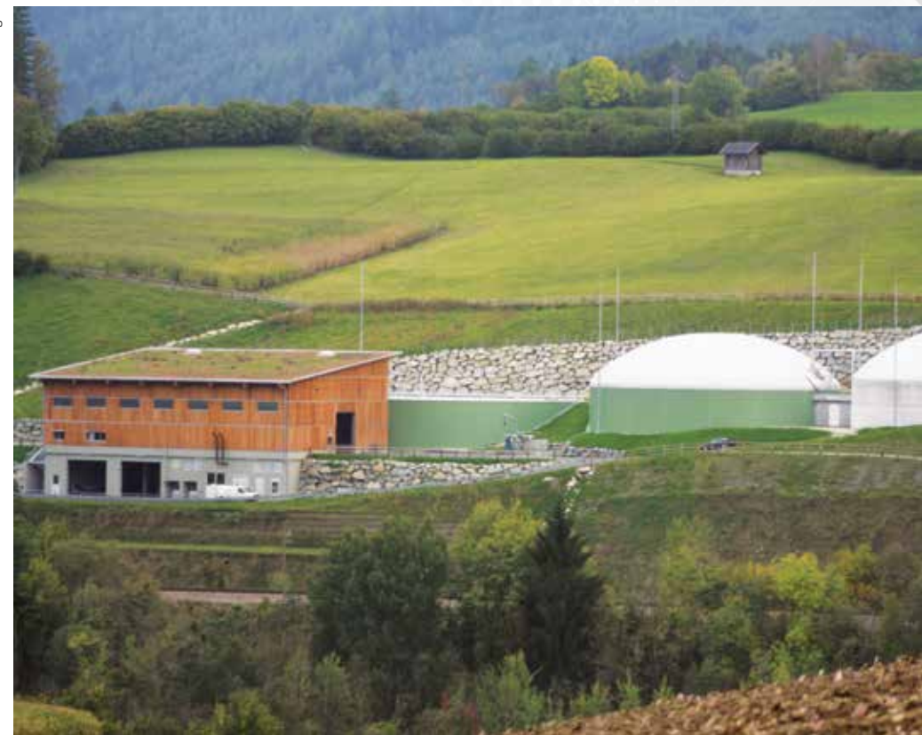
Intégration paysagère d'une unité de méthanisation.
